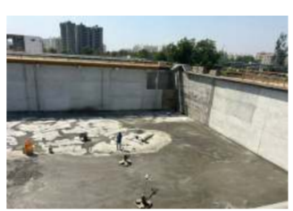
આ હેતુસર, રેવન્યુ સર્વે નં. 30/31 ખાતે 50 MLD ક્ષમતાનો અદ્યતન 'સુવેલ ડ્રીટમેન્ટ પ્લાન્ટ' બનાવવાની કામગીરી શરૂ કરવામાં આવી છે. આ પ્રોજેક્ટ પાછળ અંદાજે 110.88 કરોડ રૂપિયા (GST સહિત) નો ખર્ચ કરવામાં આવી રહ્યો છે. આ પ્રોજેક્ટની ખાસિયત એ છે કે અહીં પર્યાવરણને અનુકૂળ અને આધુનિક 'SBR બેઝ ટેકનોલોજી'નો ઉપયોગ કરવામાં આવી રહ્યો છે. પ્રોજેક્ટની પ્રગતિ અંગે માહિતી આપતા પાણીના સુત્રોએ જણાવ્યું હતું કે, અત્યાર સુધીમાં આ કામગીરીનો 70 ટકા જેટલો હિસ્સો પૂર્ણ થઈ ચૂક્યો
