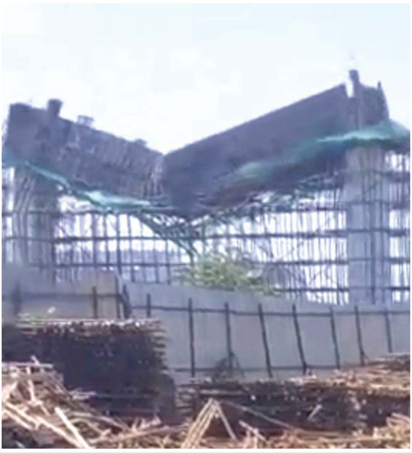
સુરતમાં નવા રેલવે સ્ટેશન MMTM માટે હાલમાં કામગીરી ચાલી રહી છે. આ કામગીરીમાં એલિવેટેડ બ્રિજનો પિલર ખામીવાળી ડિઝાઇનને કારણે બેન્ડ થઈ ગયો હતો. આમ તો આ ઘટના દોઢ માસ પૂર્વી છે પરંતુ હાલમાં વિડીયો વાઈરલ થતાં વિવાદ શરૂ થયો હતો. ખામીયુક્ત ડિઝાઇનને કારણે આ એલિવેટેડ બ્રિજનો પિલર તોડી પાડવાની ફરજ પડી છે.
